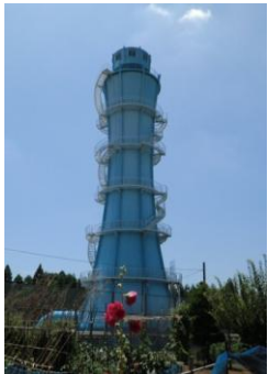
高さ 42 メートルの塔 工業用水調圧塔
